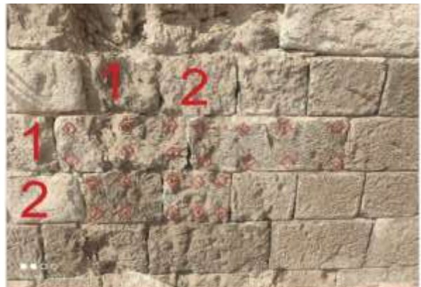
الشكل 20: الواجهة الشمالية للبرج الشمالي: (أ) مواقع قياسات صلابة الحجر؛ (ب) يوضح ملف Excel.
