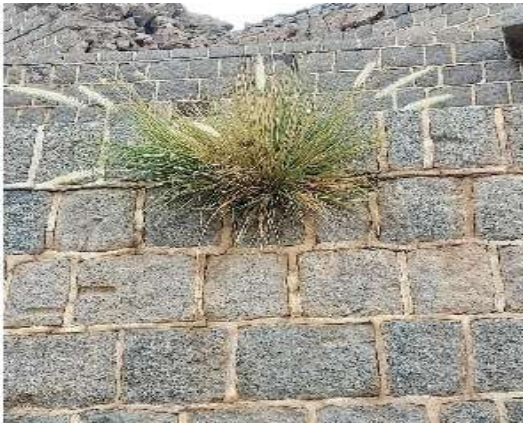
الشكل 10: صور تُظهر نمو نباتات عشبية داخل الشقوق والفواصل الحجرية بجدار قلعة القاهرة
