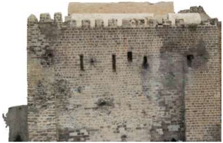
(أ) الصورة مستخرجة من نموذج Agisoft Metashape 3D ، الواجهة الشمالية للبرج
