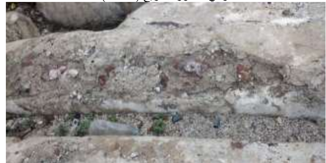
الشكل (18) الصورة توضح تدهور ماده القضااض في سواقي القلعة بسبب الحرب وظهر ماده الاحجار والياحور المستخدم في بناء السواقي الصورة بتاريخ (2025)
