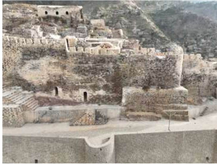
الشكل (30) توضح الصورة تآكل الأحجار والاملاح الظاهر على سور القلعة
