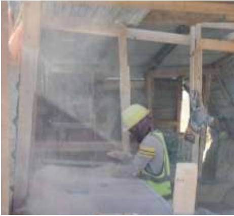
(4) بعد إكمال عملية التطفئة ويتم غريلة النورة وتنظيفه من الأحجار النافله والاغير قابلة للاستخدام
