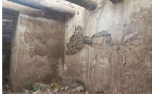
الشكل 16: يوضح انفصال طبقة الملاط عن سطح الحجر.
