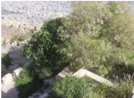
الشكل 11: الصور تُظهر نمو الأشجار داخل قلعة القاهرة بالقرب من العناصر المعمارية والأساسات.
