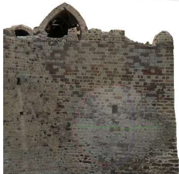
(أ) الصورة مستخرجة من نموذج Agisoft Metashape 3D ، الواجهة الشمالية للبرج
