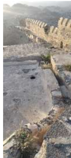
الشكل (28) البركة توضح الصورة تدهور مادة القضاض
