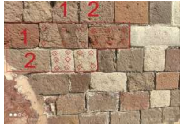
الشكل 19: الواجهة الشرقية للبرج الشمالي: (أ) مواقع قياسات صلابة الحجر؛ (ب) يوضح ملف Excel.
