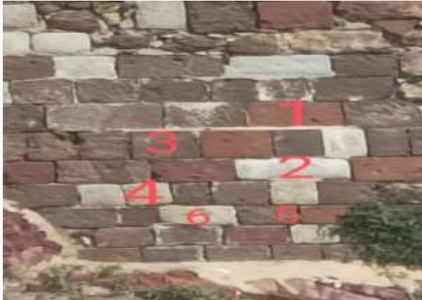
الشكل 22: مقياس الرطوبة Protimeter للواجهة الغربية
