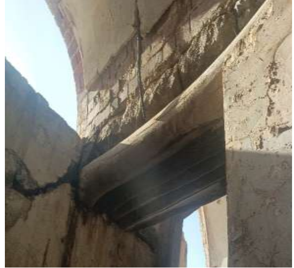
الشكل (18): يوضح الأضرار التي لحقت بالعتبات الخشبية فوق الفتحات (الأبواب والنوافذ).
