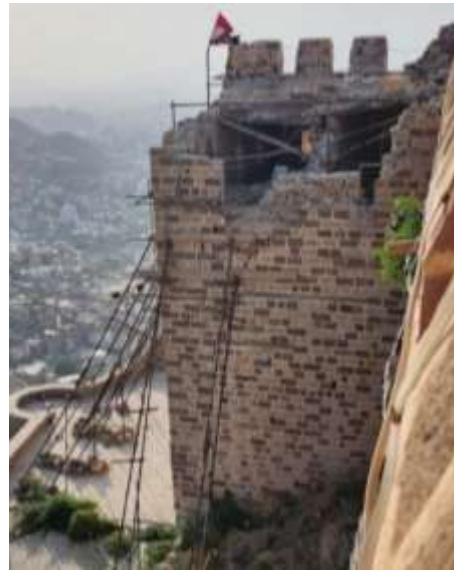
الشكل 3: يوضح الواجهة الجنوبية (2025)
