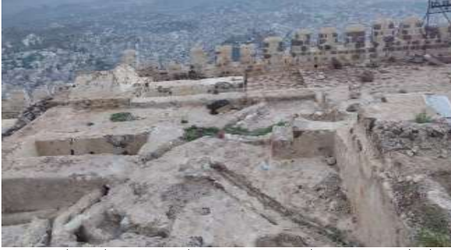
الشكل (21) توضح الصورة تدهور مواد السواقي بسبب التغير المناخي (الجفاف) الصورة بتاريخ (2025)
