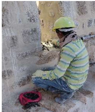
(7) عمله فرش ماده القضاض وذلك وتلميعها الشقوق على عده مراحل الشكل (26) توضح سبع عمليات للتنفيذ وإعداد مادة القضاض
