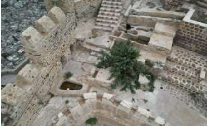
الشكل (17) الصورة توضح جزء من فلاتر المياه في قلعة قبل وصولها الى البركة الصورة بتاريخ (2025)
