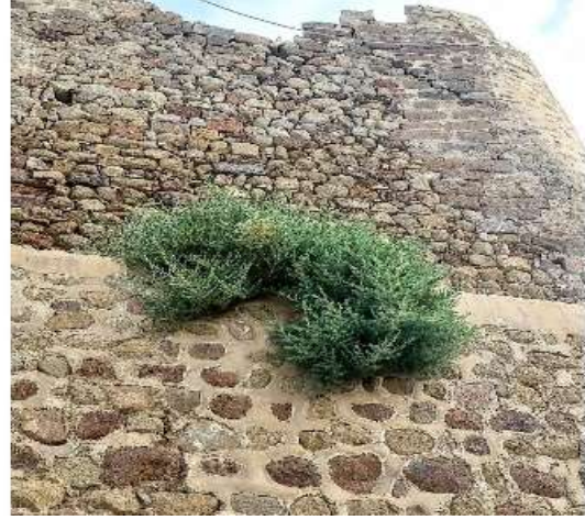
الشكل 11: صور توضح أحد مواقع نمو الشجيرات على جدار قلعة القاهرة، حيث تظهر النباتات متغلغلة في الشقوق والفواصل الحجرية، بما يشير إلى تأثيرها المحتمل على تماسك العناصر المعمارية.
