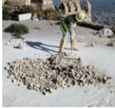
(2) ومن ثم يقوم العامل على تقليب القضاض وتفتيت الذي لم يتفتت بالتفاعل الماء
