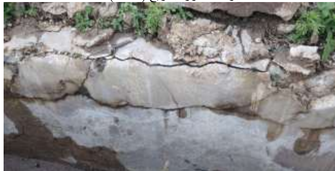
الشكل (19) الصورة توضح تدهور ماده القضااض في سواقي القلعة بسبب الحرب وظهر ماده الاحجار والياحور المستخدم في بناء السواقي الصورة بتاريخ (2025)
