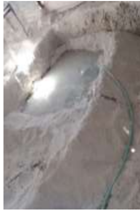
(5) ومن ثم عملية التخمير النورة بالماء ما بين 2-4 اسابيع ويتم ذلك الخلطة شبه يوميا باقدام العمال
