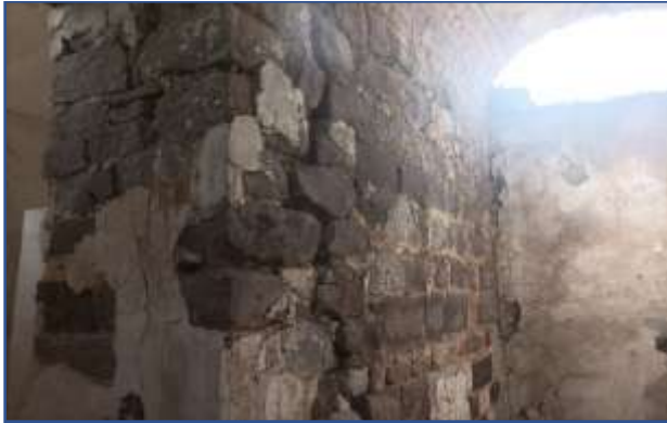
الشكل 16: يوضح انفصال طبقة الملاط عن سطح الحجر.
