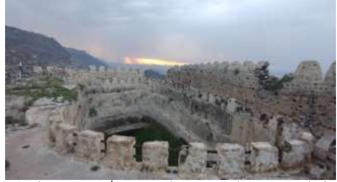
الشكل (20) توضح الصورة تدهور المواد وانهار أجزاء من جدار البركة بسبب تغير المناخ (الجفاف) والنزاعات الصورة بتاريخ (2025)
