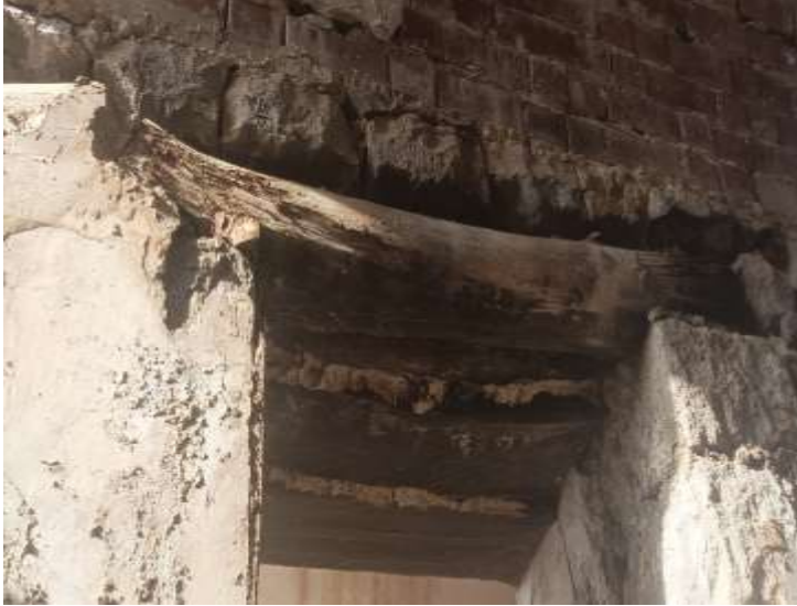
الشكل (18): يوضح الأضرار التي لحقت بالعتبات الخشبية فوق الفتحات (الأبواب والنوافذ).
