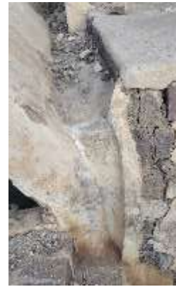
الشكل (16) الصورة توضح سمك مادة القضااض المستخدمة في تكسيه السواقي الصورة بتاريخ (2025)
