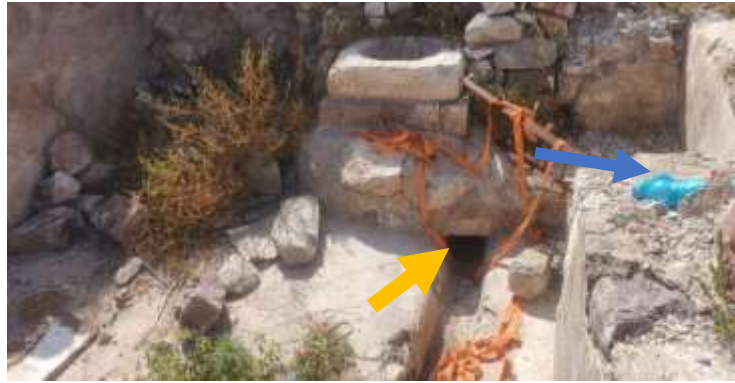
الشكل (10): توضح الصورة خزان ماء الشرب ويمثل السهم الاصفر مدخل الماء من السواقي للتعبئة الخزن ويمثل السهم الأزرق مخرج الماء الفائض من الخزان عبر سواقي مدفونة
