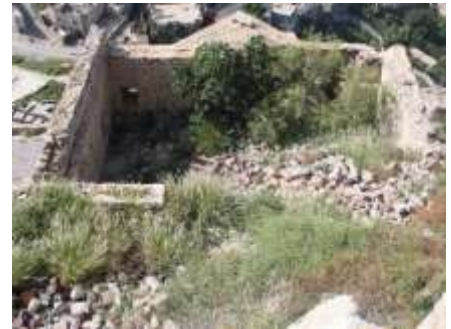
الشكل 11: الصور تُظهر نمو الأشجار داخل قلعة القاهرة بالقرب من العناصر المعمارية والأساسات.
