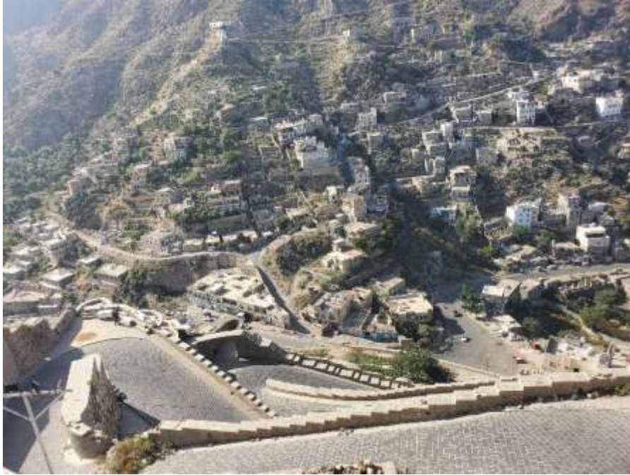
الشكل (32) توضح الصورة التوسع العمراني
