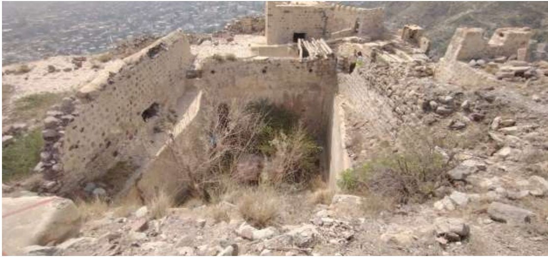
الشكل (25) توضح الصورة استخدام الحجر الطبيعي في بناء البركة القصر.
