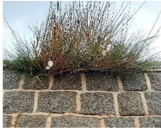
الشكل 10: صور تُظهر نمو نباتات عشبية داخل الشقوق والفواصل الحجرية بجدار قلعة القاهرة
