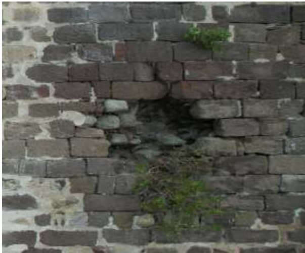
الشكل 9: نمو شجيرة من عائلة المصطكي على الواجهة الشمالية للبرج دون تأثير مباشر على الاستقرار الهيكلي
