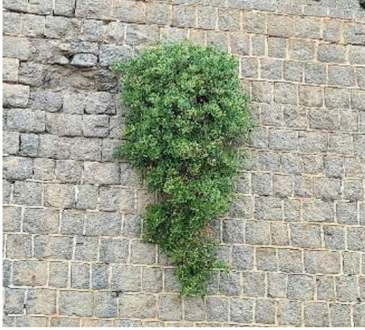
الشكل 11: صور توضح أحد مواقع نمو الشجيرات على جدار قلعة القاهرة، حيث تظهر النباتات متغلغلة في الشقوق والفواصل الحجرية، بما يشير إلى تأثيرها المحتمل على تماسك العناصر المعمارية.
