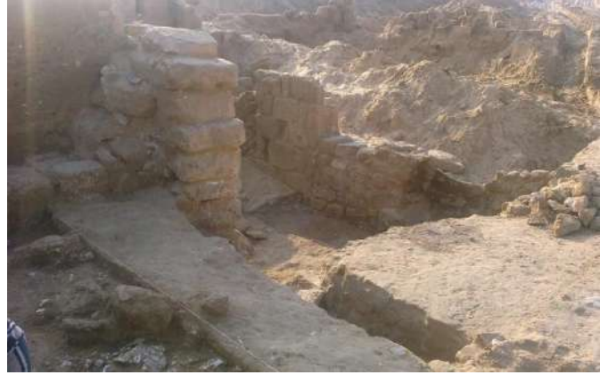
صور أضرار ميناء غزة القديم – البلاخية غزة
